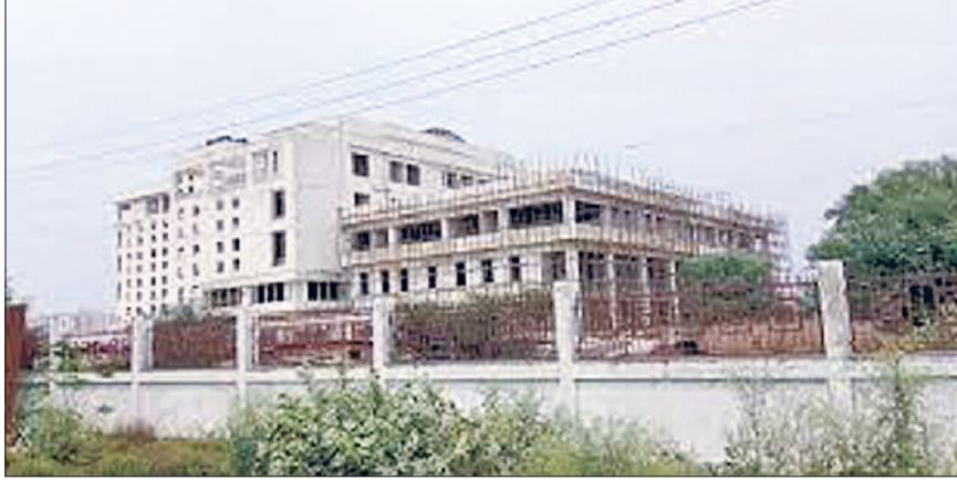
सोनीपत। नगर निगम की निर्माणाधीन हाईटेक इमारत।
